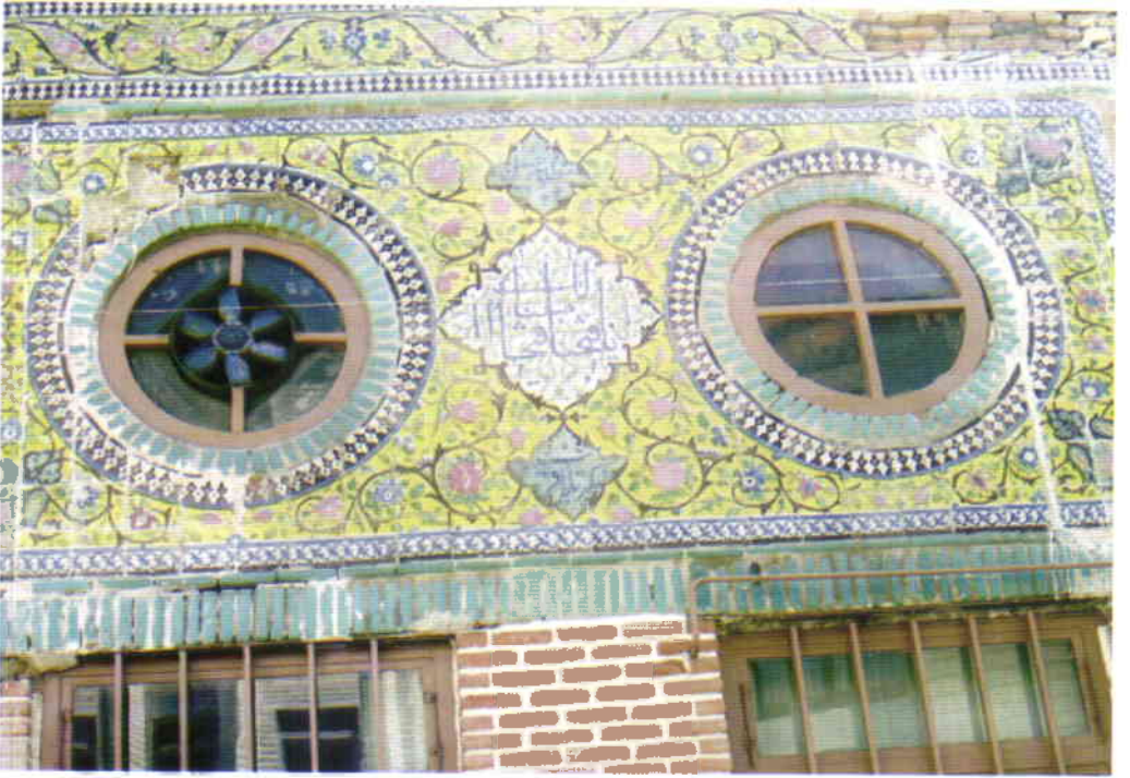
Urmiya. Avşarların təmir edib qoruduqları məscid binası
